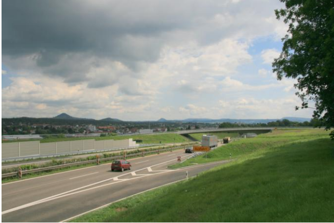
Blick auf die Anschlussstelle mit Brücke über die B 10
